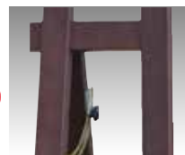
開き止めは金具を使用しています。
